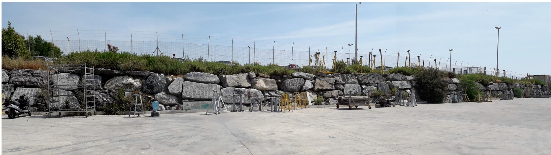
Ripresa n 9 – dal porto turistico verso il margine ovest dell'area di intervento: il dislivello non permette di vedere l'area
